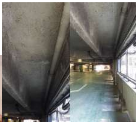
Plancher RDC Structure béton poteaux poutres planchers préfabriqués + flocage et réseaux
