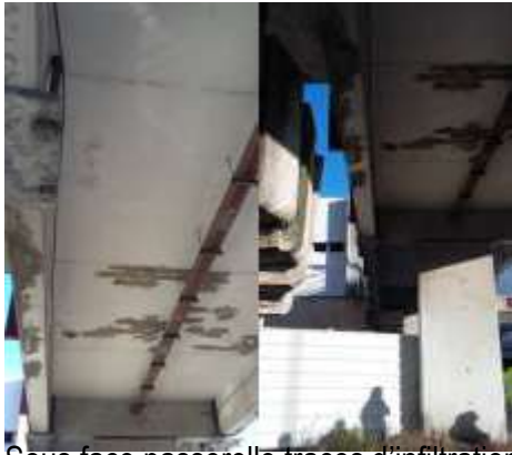
Sous face passerelle traces d'infiltrations provenant des fissures du tablier
