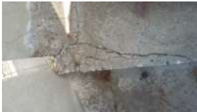
Escalier accès passerelle (béton éclaté aciers rouillés marches et garde-corps)
