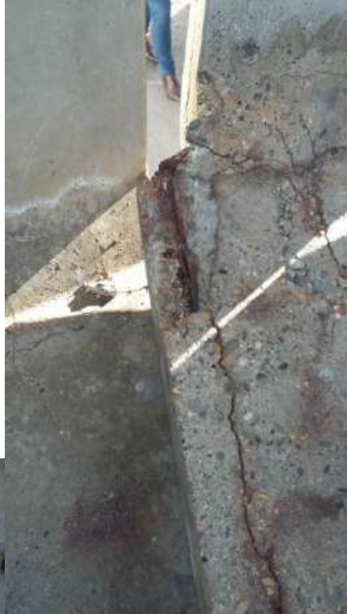
Escalier accès passerelle (béton éclaté aciers rouillés marches et garde-corps)
