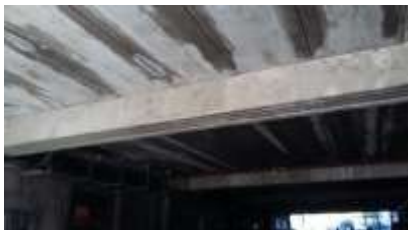
Plancher précontraint conservé
