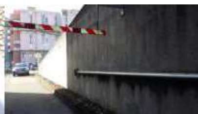
Rampe accès RDC haut et bas présence de mousses anciennes sur les bétons
