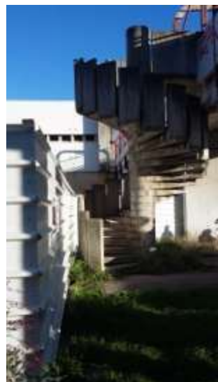
Escalier béton dégradé accès passerelle
