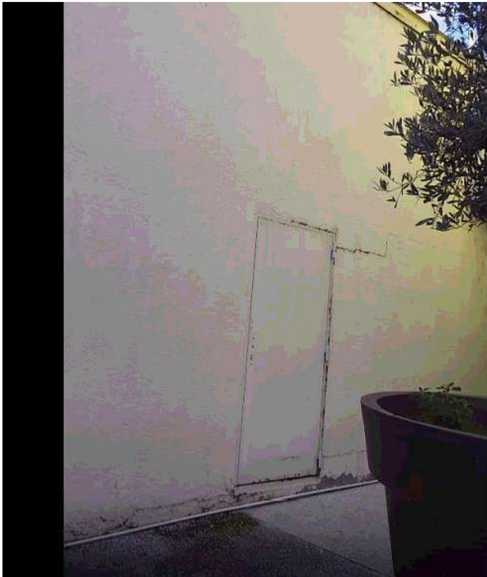
Microfissures anciennes façade Nord Carrefour
