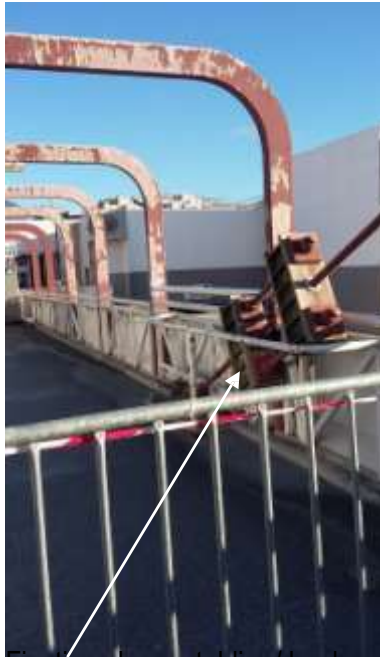
Fixations basse tablier / hauban
