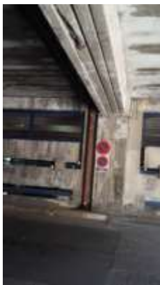
Poutres béton jumelée dégradée par un véhicule (ancienne dégradation)
