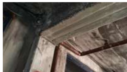
Exemple d'appui poteau / poutre
