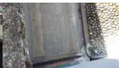
Rampe accès RDC haut et bas présence de mousses anciennes sur les bétons
